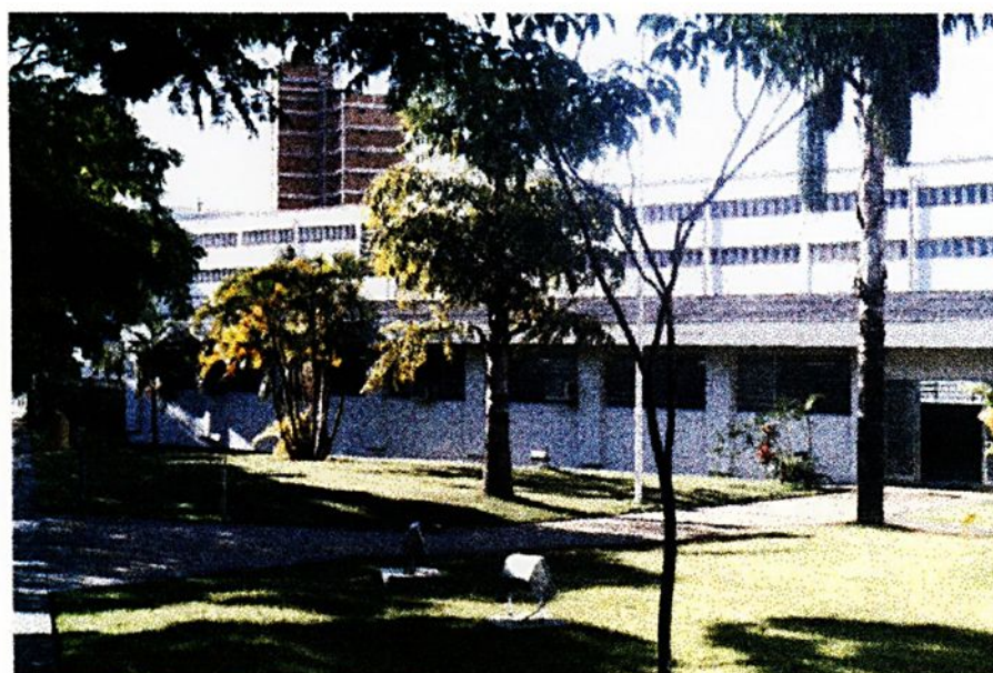
FOTO 2: Fachada da Faculdade de Odontologia de Bauru - USP FONTE: Arquivo da Assessoria de Imprensa da PCAB/USP
