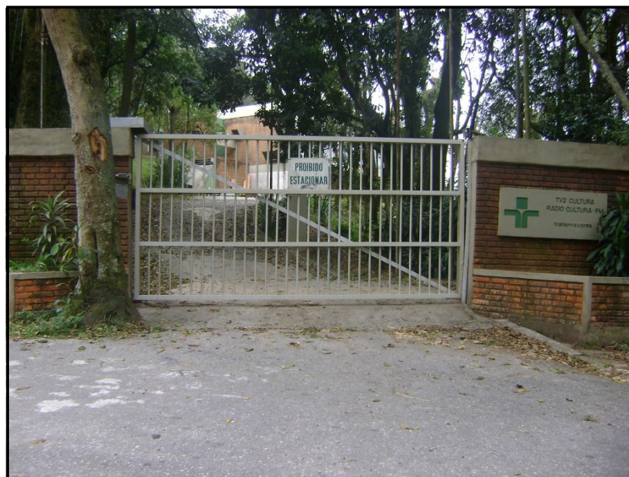
Foto 05: Área em concessão para a Rede Cultura de Televisão, para instalação de uma torre de transmissão no Pico do Papagaio.
