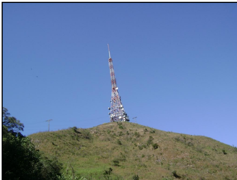
Foto 02: Torre de transmissão da Rádio e Televisão Bandeirantes Ltda.
