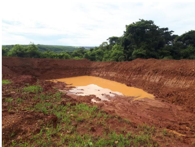
Figura 5 - Escavação realizada pela empresa.
