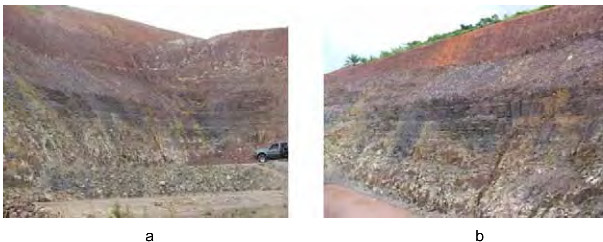
Figura 26 – Vista geral do argilito siltoso arroxeadado laminado (ED6); a) e b): observar o acamamento plano-paralelo e a variação superficial da coloração.
