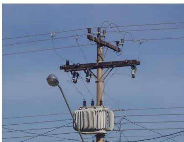
Figura 4.22: Transformadores de distribuição instalados em postes.
