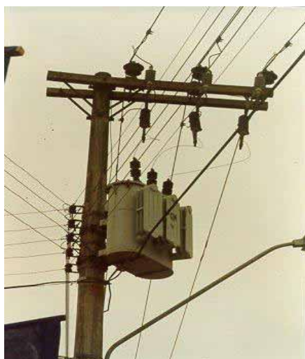
Figura 4.22: Transformadores de distribuição instalados em postes.
