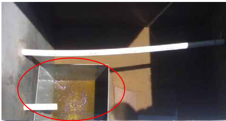
Figura 6.6: Separação do óleo isolante assinalado em vermelho da água enviada para o esgoto através da tubulação de PVC.
