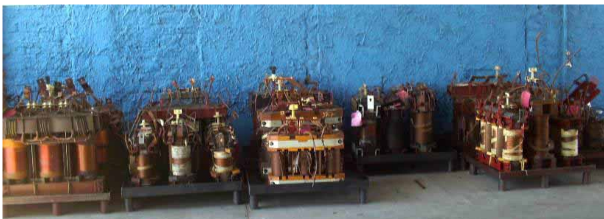
Figura 4.13: Enrolamentos já montados no núcleo de transformadores reformados.
