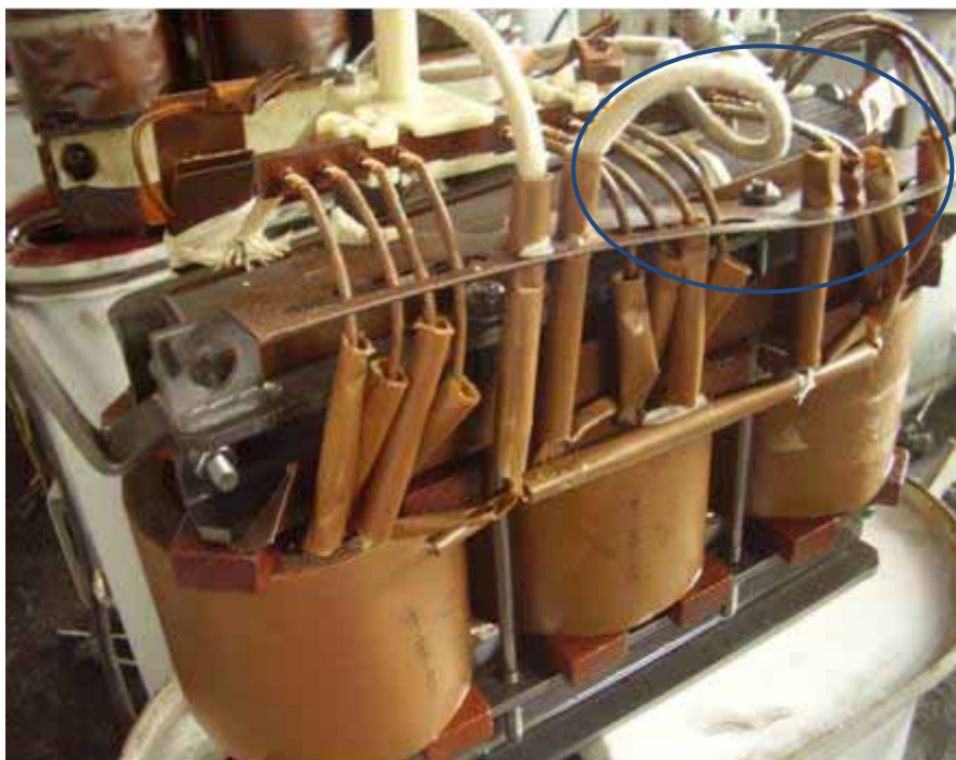
Figura 4.5: Defeito construtivo destacado em azul.
