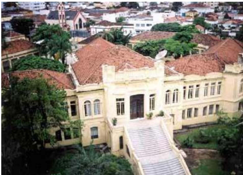
Foto 2: Vista Superior da Escola
