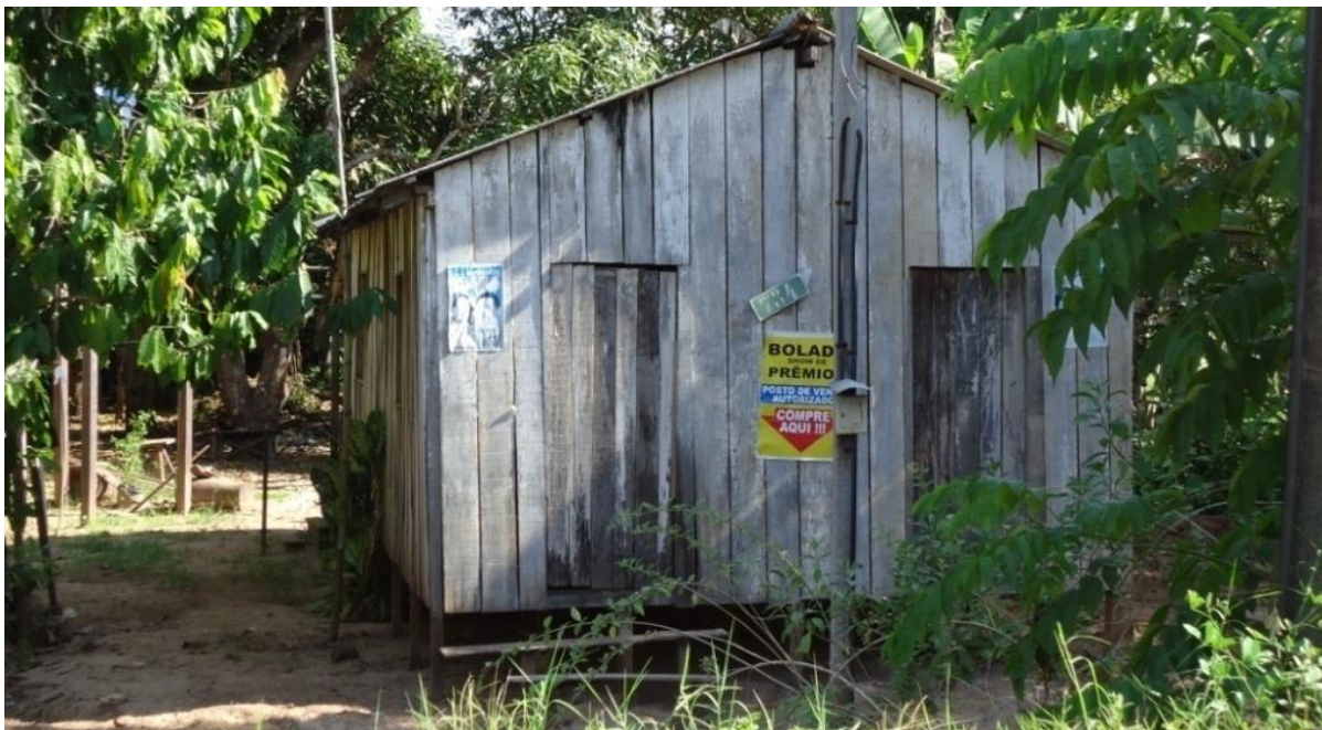
Foto 15 - Casa na Rua Maicá, Bairro do Maicá, cidade de Santarém.
