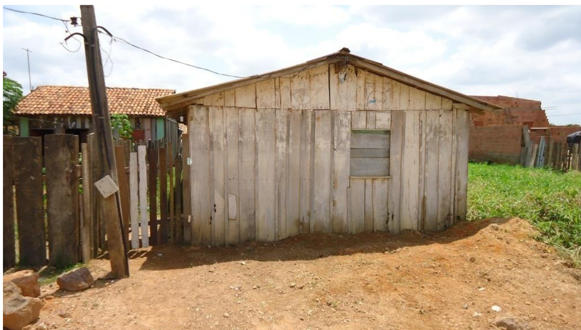
Foto 22: Residência na Rua Rio Grande do Norte, Núcleo Cidade Nova.
