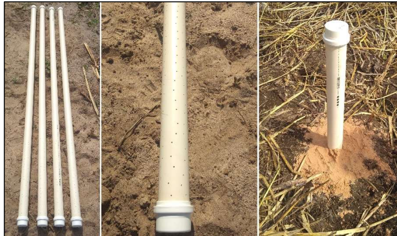
Figura 10 – Preparo dos canos para instalação dos poços.
