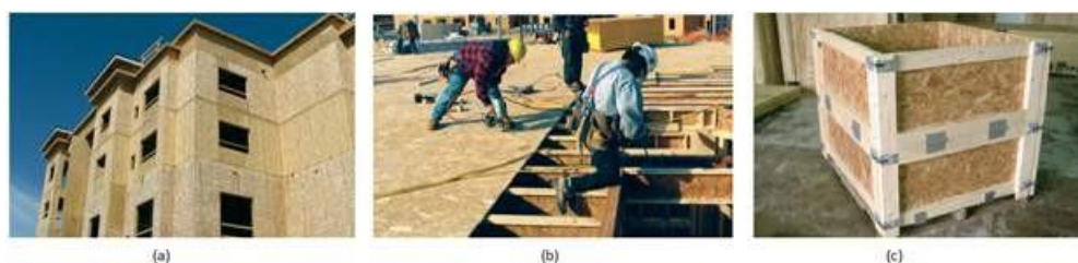
Figura 3 – Utilização de painéis OSB.
