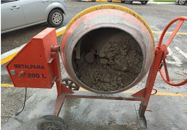
Figura 32: Produção da argamassa em betoneira.
