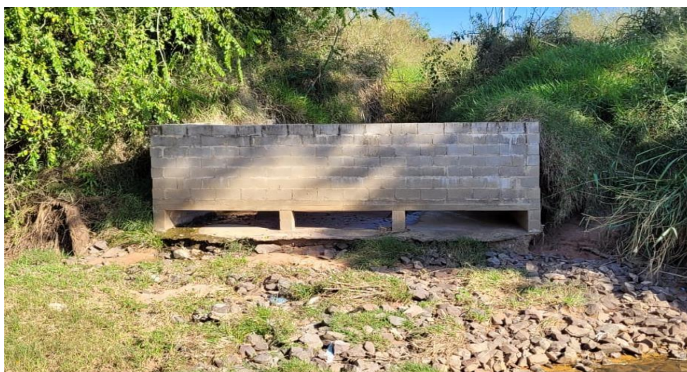
Figura 50 - Dissipador de energia de água pluvial do novo residencial, córrego do Cedro próximo do Local 2.
