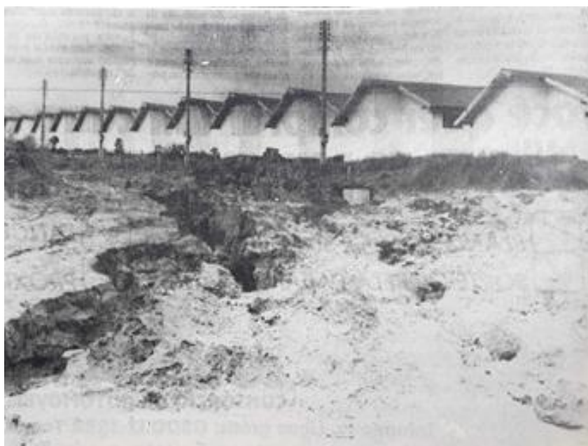
Figura 14 - Ravinamento em ruas sem asfalto no Conjunto Habitacional Ana Jacinta, na década de 1990.
