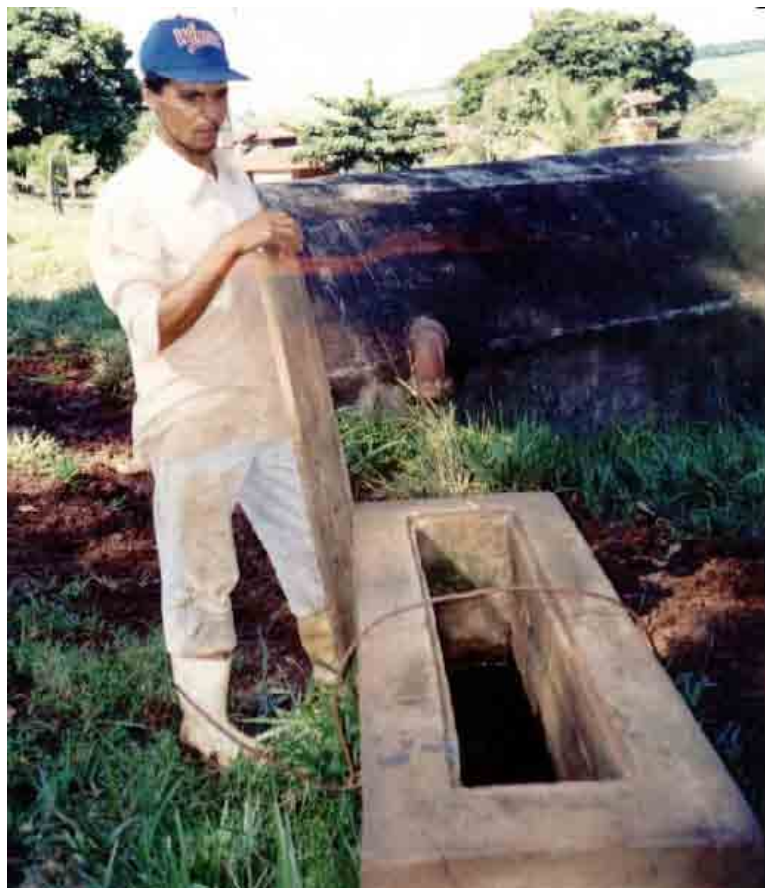
Figura 02. Caixa receptora da água de mina com mais de 50 anos.
