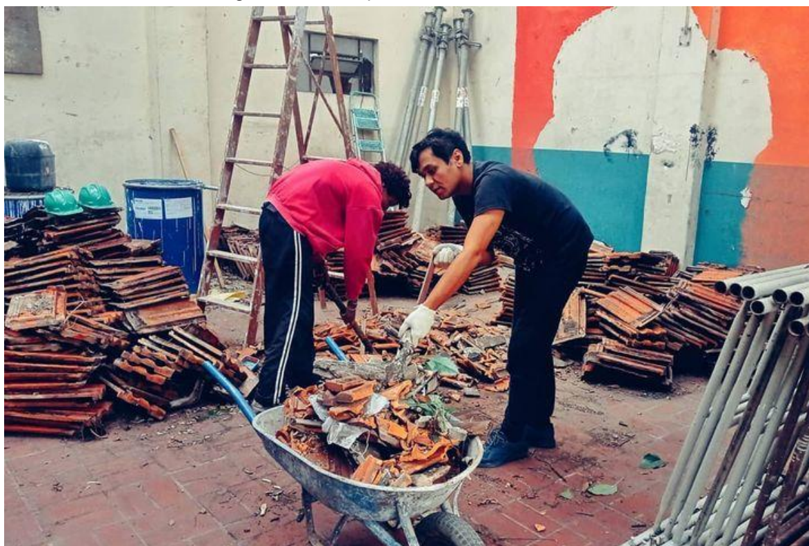
Figura 7 – Manutenção da área externa da Casa Amarela
