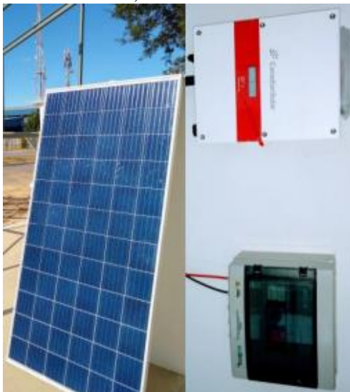
Figura 6 – Módulo fotovoltaico, inversor de corrente elétrica e string box.
