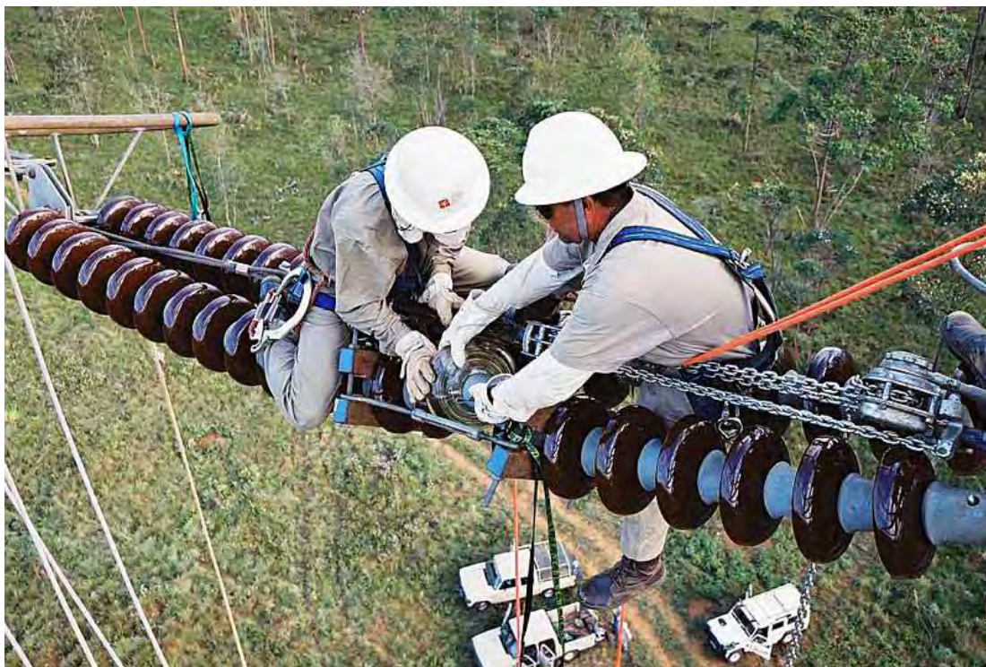
Figura 8 - Manutenção em linha desenergizada (fonte: ISA CTEEP, 2008).
