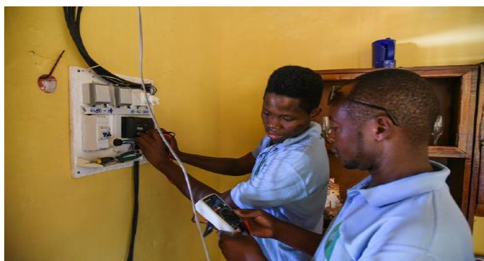
Figura 7: Manutenção garantida pela FRES nos sistemas SSC.
