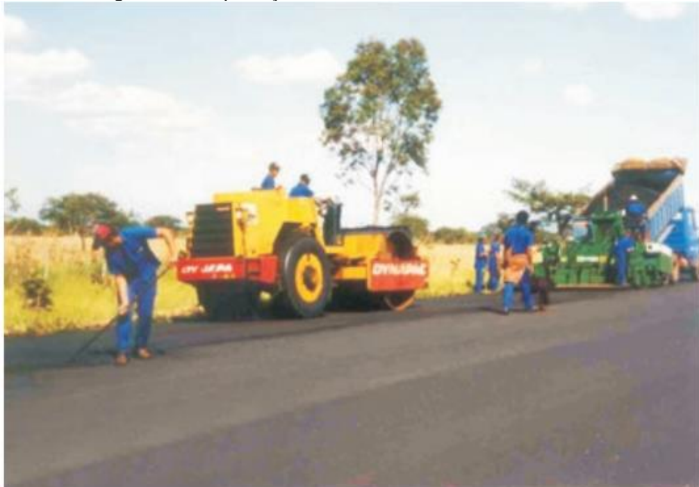
Figura 10 - Aplicação de PMF com vibro-acabadora.
