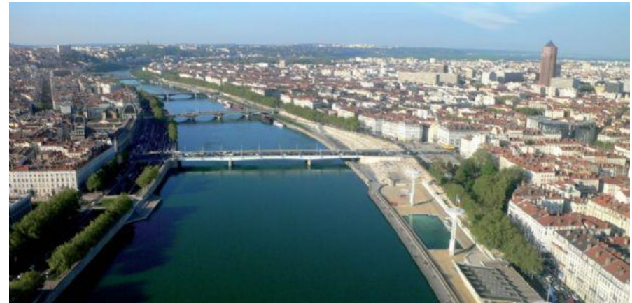
Figura 58 – Intervenção junto à Pont de la Guillotière. Fonte: Revista aU nº 234, ano 28.
