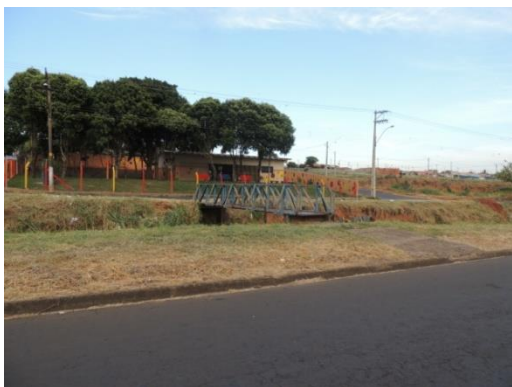
Figura 36 – Pontes que dão acesso às escolas. Fonte: Arquivo pessoal.
