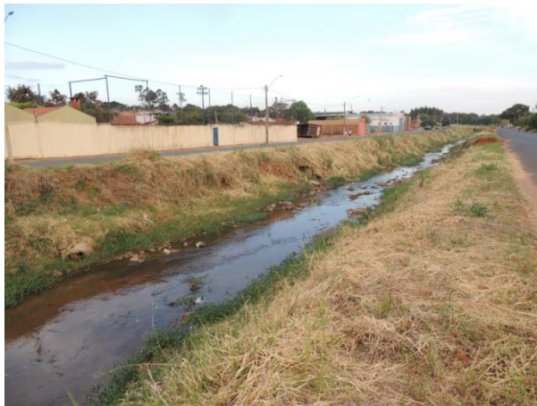
Figura 34 – Situação do trecho sem canalização no Córrego da Estiva. Fonte: Arquivo pessoal.
