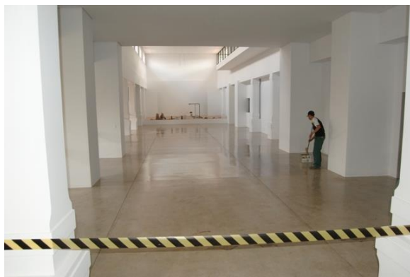
Figura 18– Descaracterização do prédio. Fonte: http://www.centroculturalnh.com.br/
