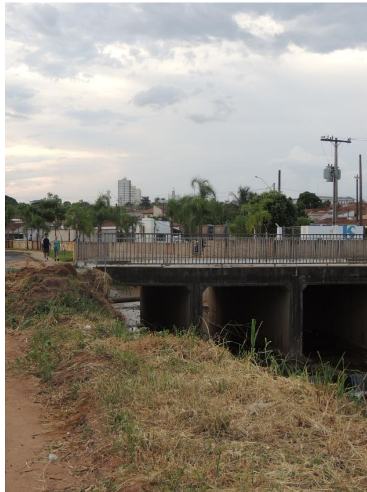
Figura 32 – Ponto de interrupção da canalização do Córrego da Estiva. Fonte: Arquivo pessoal.
