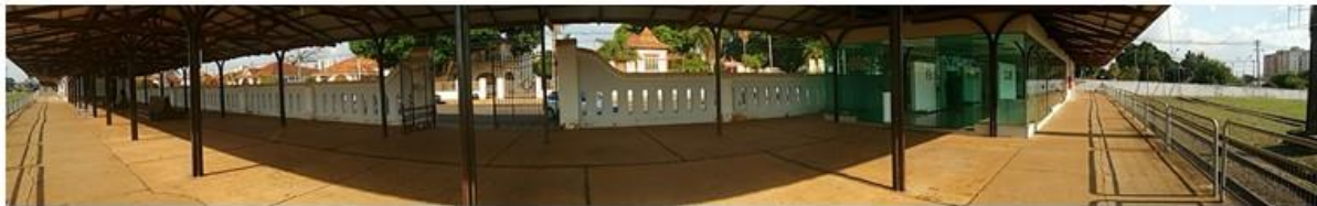
Panorâmica do acesso ao embarque, estação e trecho do armazém. Foto: Autora, 2017.
