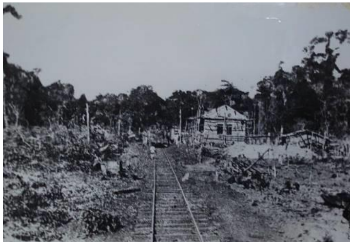
Figura 36- Construção de uma estação em meio à mata, 1906.
