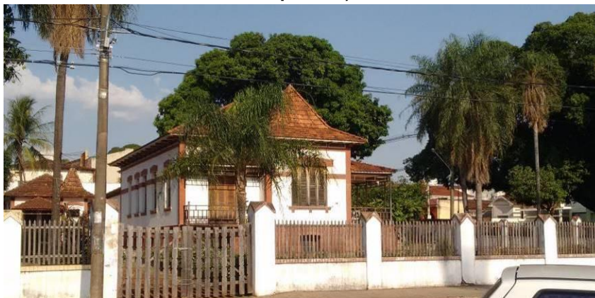
Figura 82- Residência do diretor da NOB em Campo Grande (denominada por Arruda de 'casa da Inspetoria')
