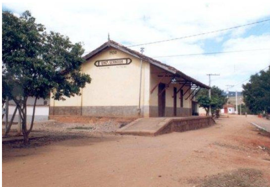
Figura 80- Estação Engenheiro Schnoor
