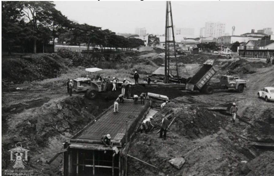
Figura 59- Foto de 1982. Obras de canalização do Córrego das Flores em Bauru, atual Avenida Nações Unidas.
