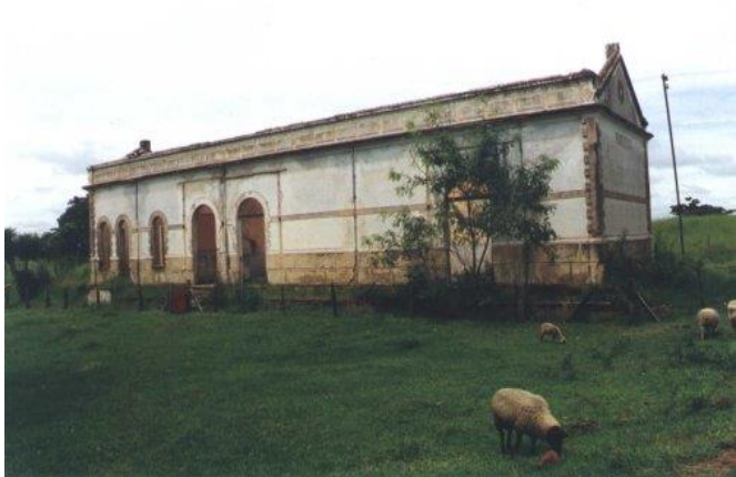
Figura 76- Estação Machado de Mello em Mirandópolis (SP)
