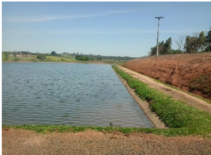
Figura 10. Vista geral da lagoa facultativa do município de Pirangi, SP.
