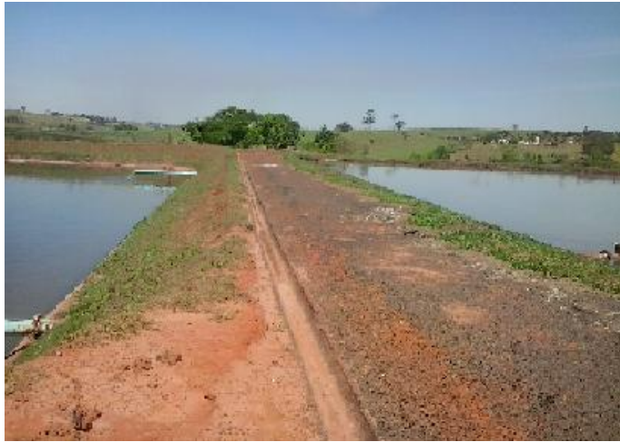
Figura 8. Vista do ponto de encontro entre as lagoas anaeróbia e facultativa.
