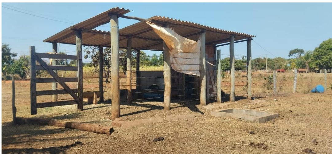
Figura 11 – Um dos muitos exemplos de currais que podem ser encontrados nos estabelecimentos rurais dos Assentamentos Pontal do Faia (Três Lagoas-MS) e Alecrim, Selvíria-MS, pode-se observar a falta de uma estrutura adequada.
