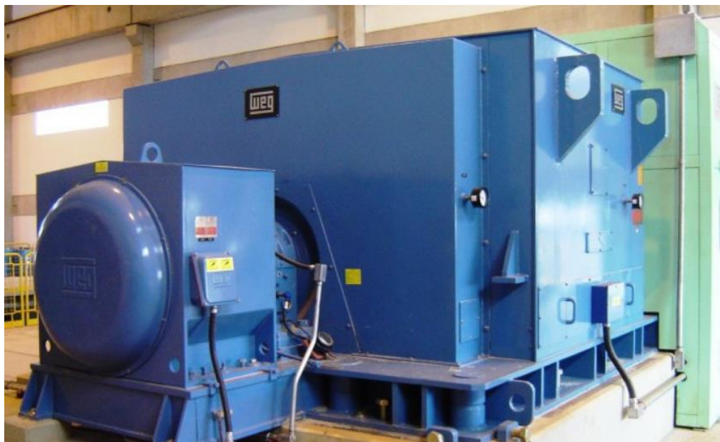
Figura 46 – Gerador síncrono.
