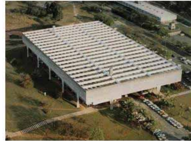
Figura 15: Vista Aérea do Edifício Fonte: HESPANHOL, 2010
