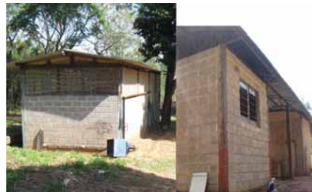
Figura 75 Unidades demolidas. Fonte: Acervo da autora
