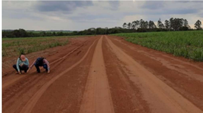
Figura 35 – Ausência de poças d'água no Trecho 1 Estrada 1
