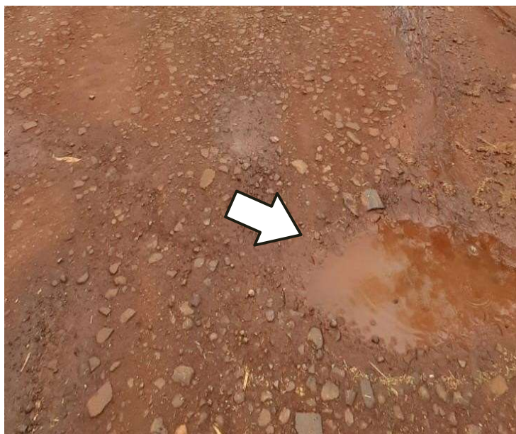
Figura 6 – Buraco ou panela
