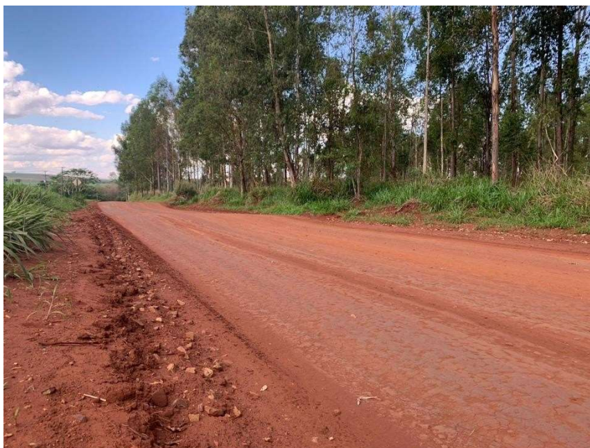
Figura 4 – Drenagem lateral inadequada
