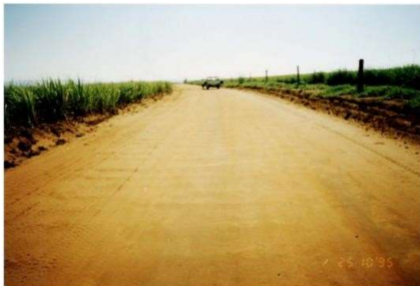
Figura 5 – Corrugações de severidade baixa
