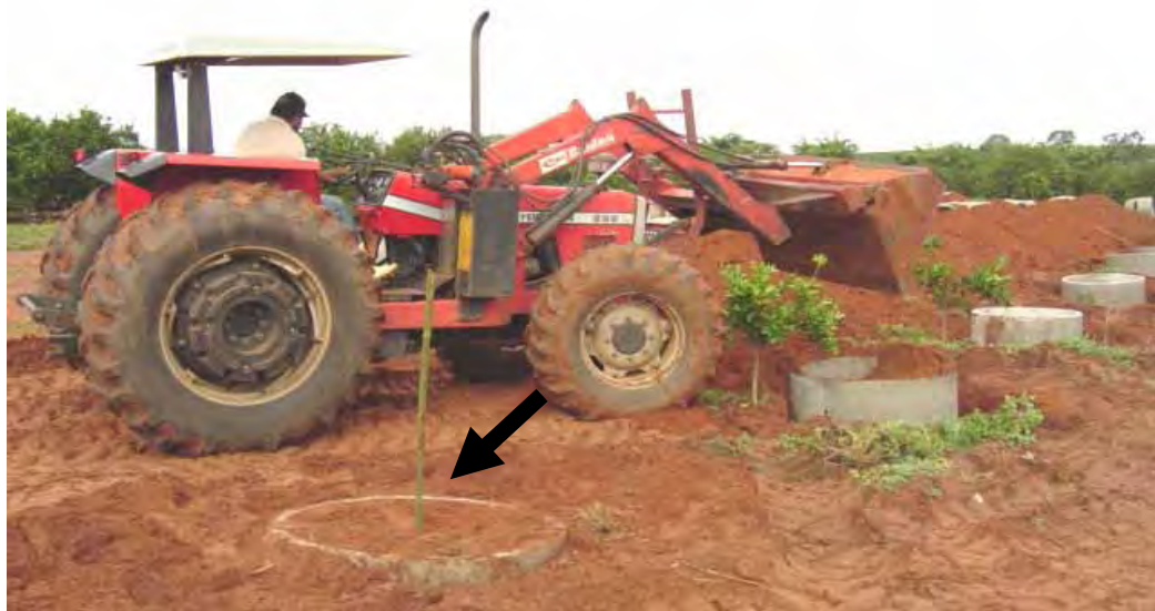
Figura 1. Trator equipado com pá-carregadeira utilizado para o preenchimento das manilhas no processo de construção das microparcelas (a seta indica uma microparcela pronta).
