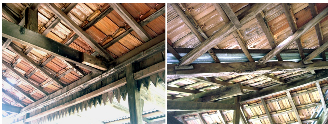
Figura 25 – Madeiramento da cobertura do guenkan(varanda) da Escola Japonesa. Fonte: Arquivo Pessoal, 2013
