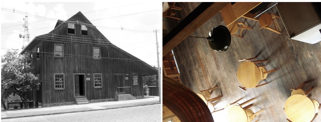
Figura 47 – Museu do Pão de Ilópolis – RS, Antigo Moinho restaurado e seu interior.
