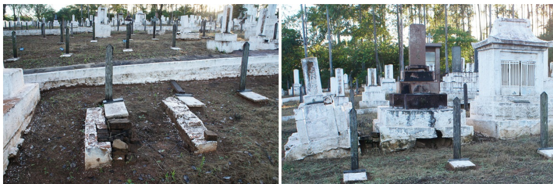
Figura 23 – Efeito da erosão nos túmulos. Fonte: Acervo pessoal, 2013.
