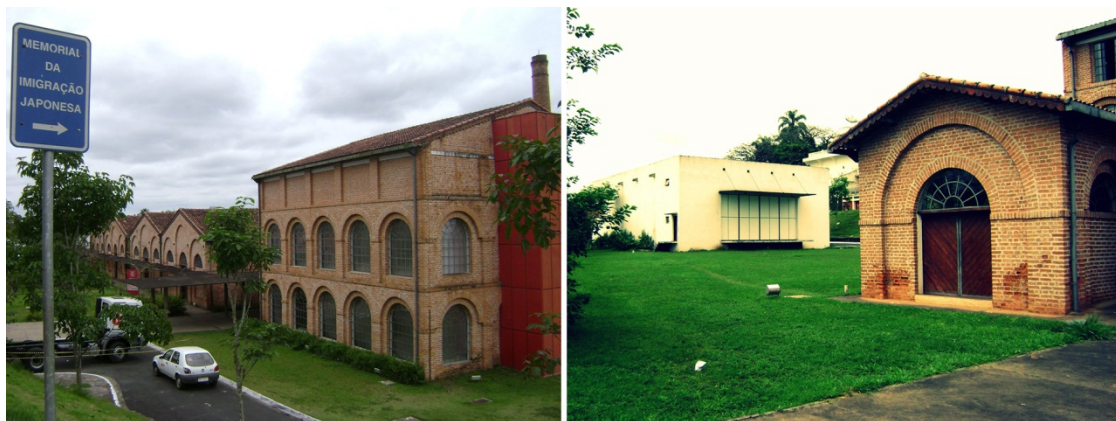
Figura 40 – Museu da Imigração Japonesa de Registro – SP, Intervenções em meio ao conjunto antigo.
