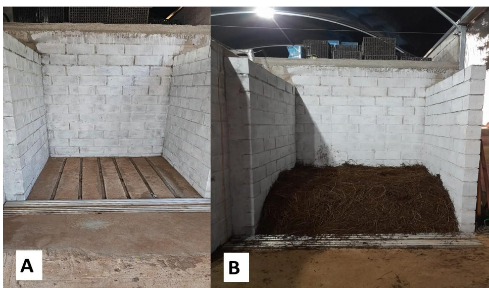
Figura 2. Estrutura do bunker com piso de aeração forçada (A); Bunker com substrato em compostagem fase I (B).
