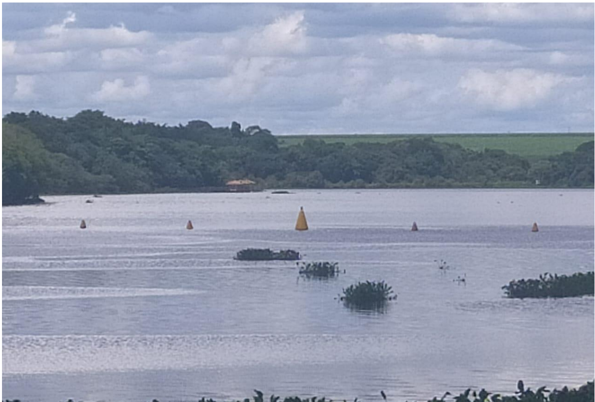
Figura 17: Reservatório da Usina Hidrelétrica de Canoas II.
