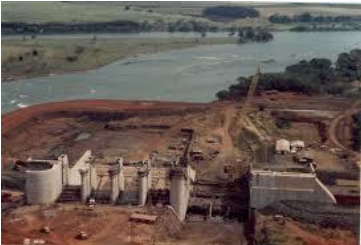
Figura 14: Construção da Usina Hidrelétrica de Canoas II.
