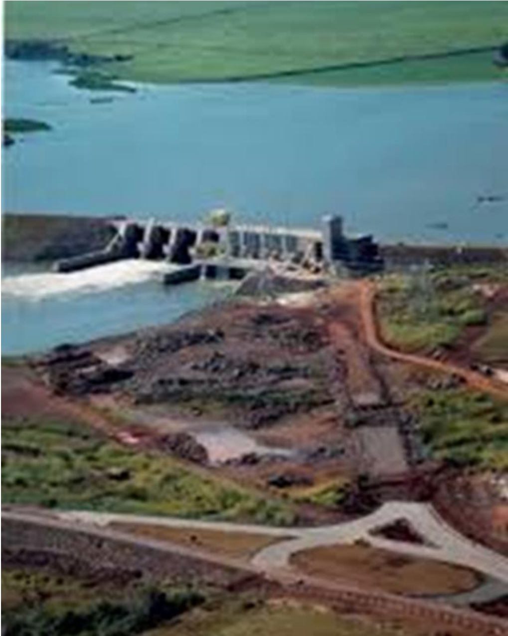
Figura 15: Construção da Usina Hidrelétrica de Canoas II.
