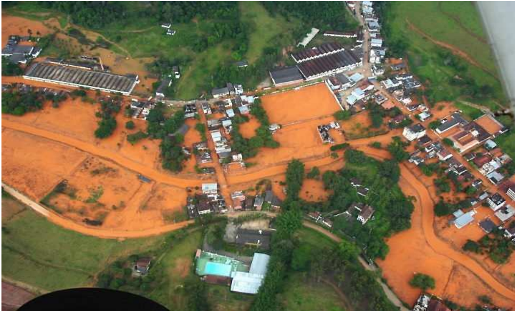
Figura 1.1. Rompimento de dique na Mineradora Rio Pomba Cataguases Ltda em Mirai (MG).
