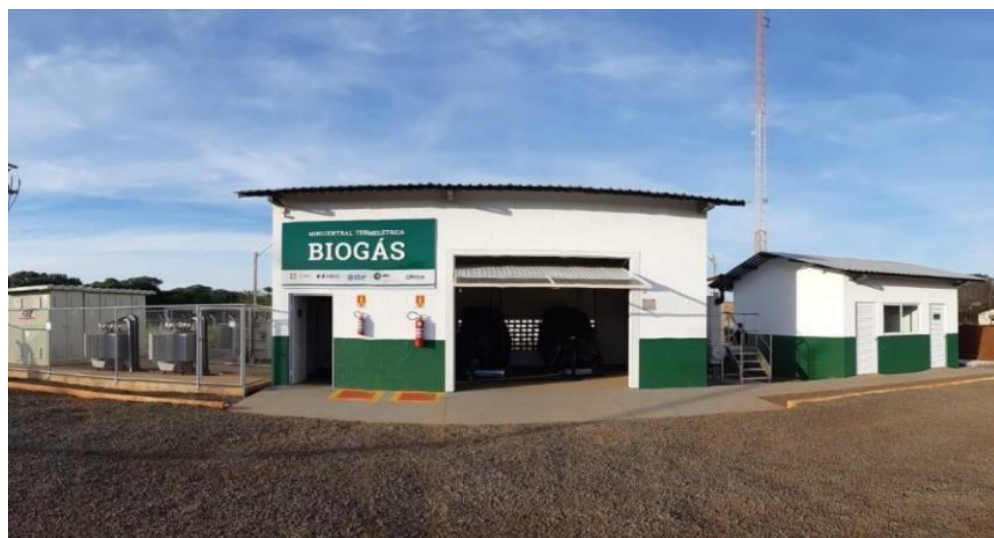
Figura 13 - Mini Central Termelétrica de 480 kW de potência instalada.
