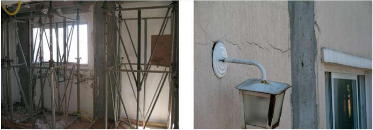
Figura 4.27 – Reforço com a introdução de pilar de concreto armado
