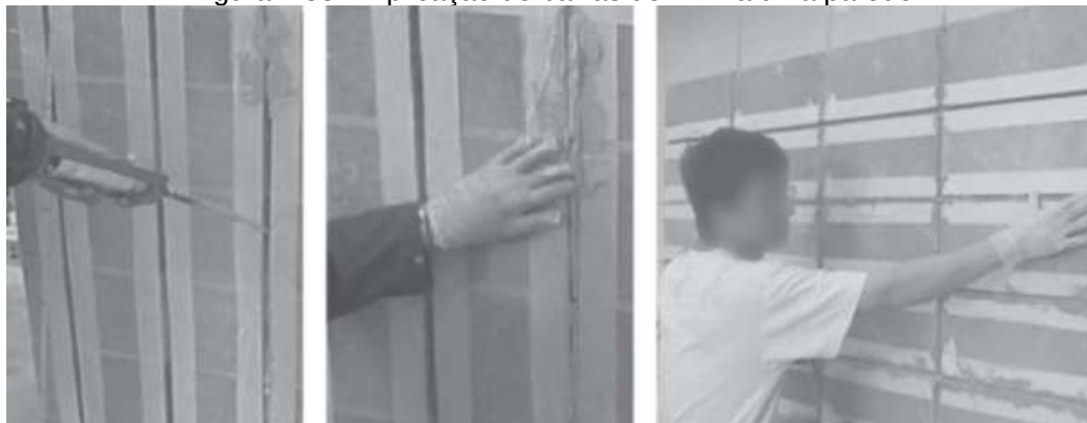
Figura 4.33 – Aplicação de barras de PRF a uma parede
