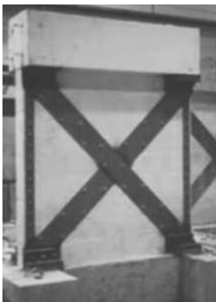
Figura 4.29 – Contraventamento metálico em alvenaria
