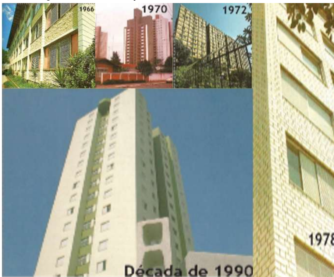
Figura 2.15 – Construções em alvenaria estrutural no Brasil
