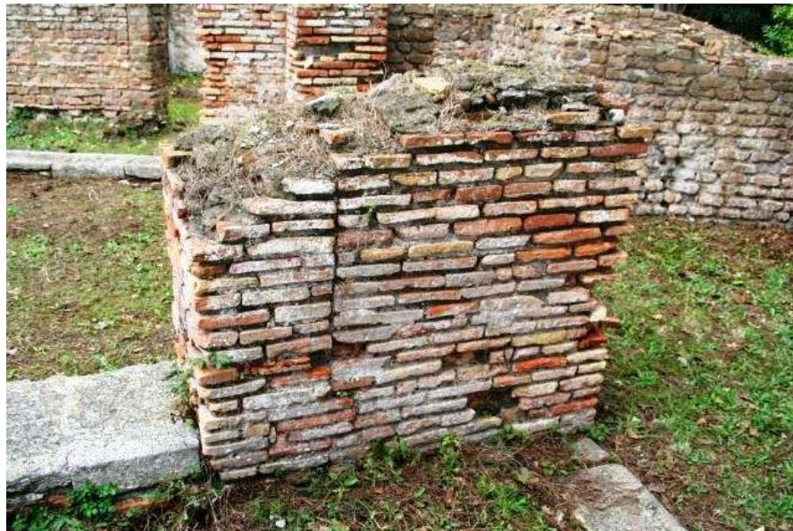
Figura 2.5 – Parte de uma parede opus latericium
