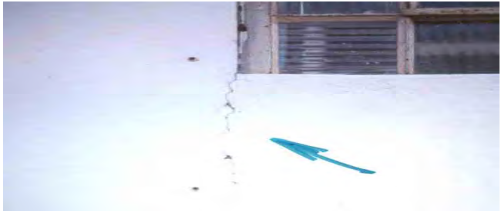
Figura 4 - Trinca provocada por acúmulo de água em peitoril de janela
