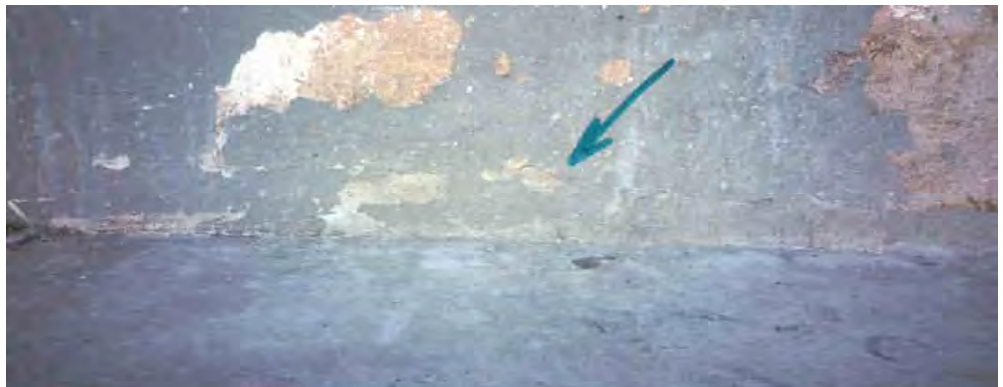
Figura 5 - Trinca em parede e adiantado processo de degeneração em argamassa devido à contínua presença de umidade.
