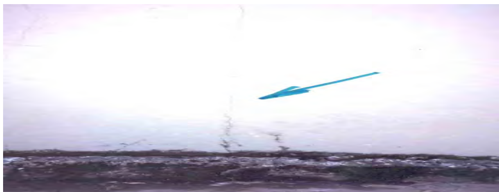
Figura 6- Trinca vertical causada por movimentações higroscópicas em parede de tijolos comuns e argamassa de cimento e areia.
