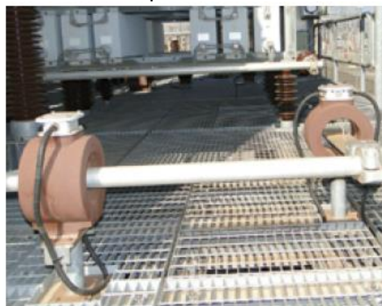
(b) Medição da corrente nos barramentos
