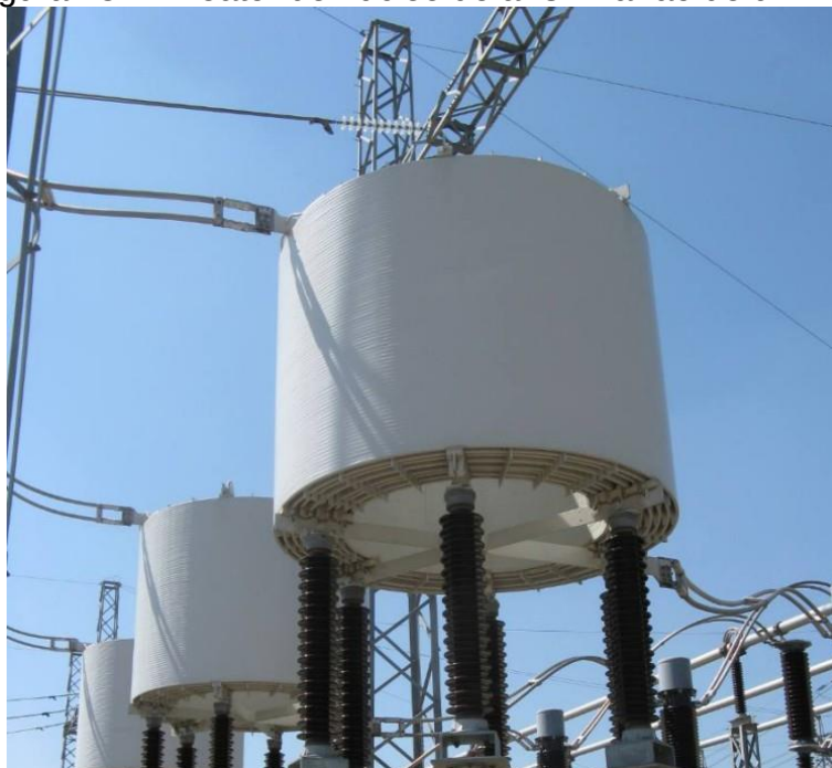
Figura 13 — Reator de núcleo de ar similar ao de um FSC
