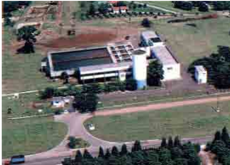
ESTAÇÃO DE TRATAMENTO DE ÁGUA – ETA II
