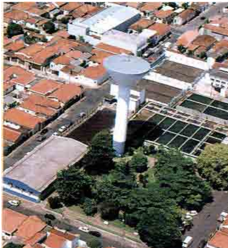
ESTAÇÃO DE TRATAMENTO DE ÁGUA – ETA I
