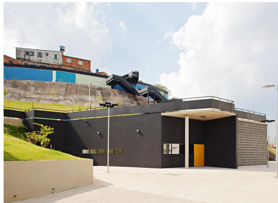
Figura 48: Edifício da informática com o mirante na cobertura do edifício
