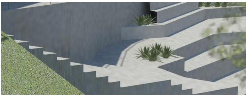
Figura 71: Vista de algumas das jardineiras junto às escadas
