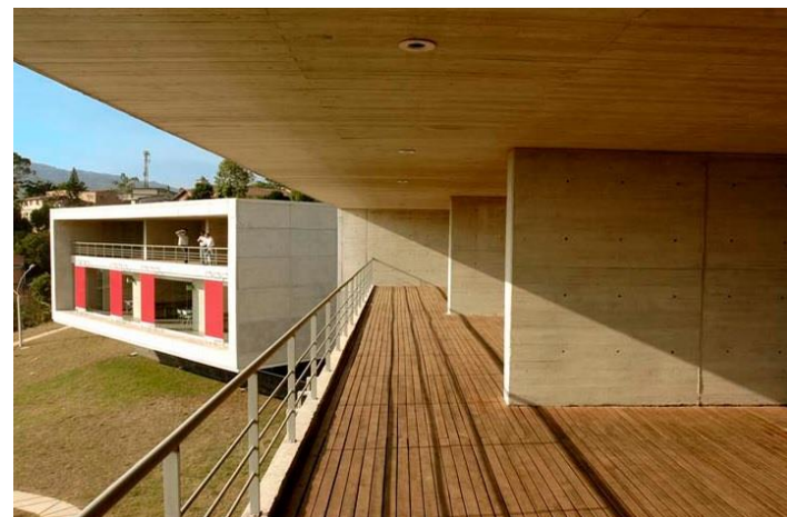
Figura 42: Detalhe dos mirantes dos edifícios.
