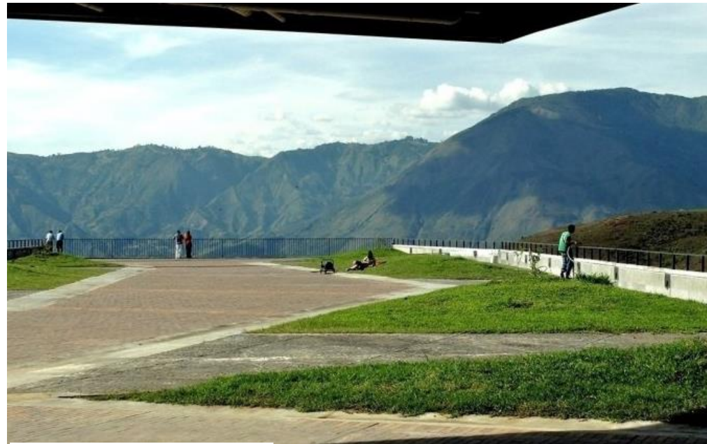
Figura 37: Vista Geral do pátio livre acima da edificação.
