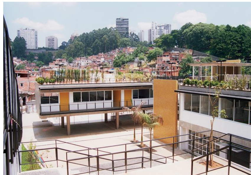
Figura 50: Vista Geral dos Blocos.
