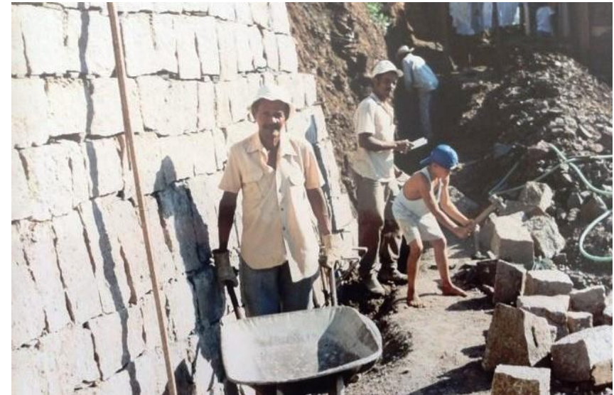
Figura 26: Mutirão para construção dos muros de contenção.
