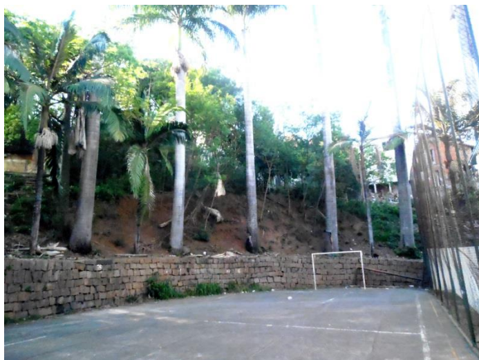
Figura 53 : Vista da quadra de futebol atrás da igreja com detalhe para uma das casas em situação de risco
