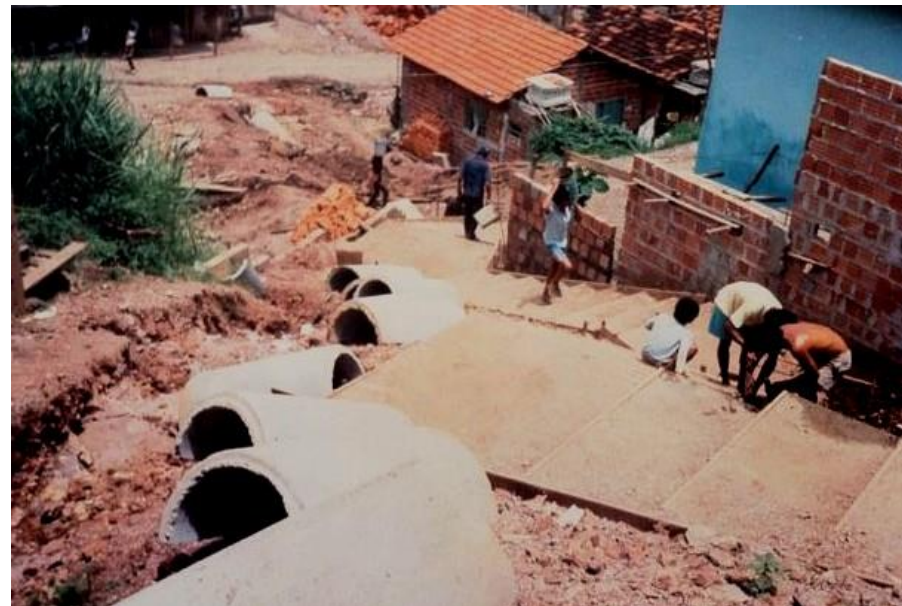
Figura 29: Construção de uma das escadarias pela população.
