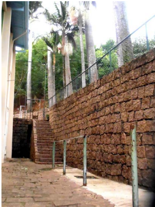
Figura 25: Vista de um dos muros de contenção da favela.
