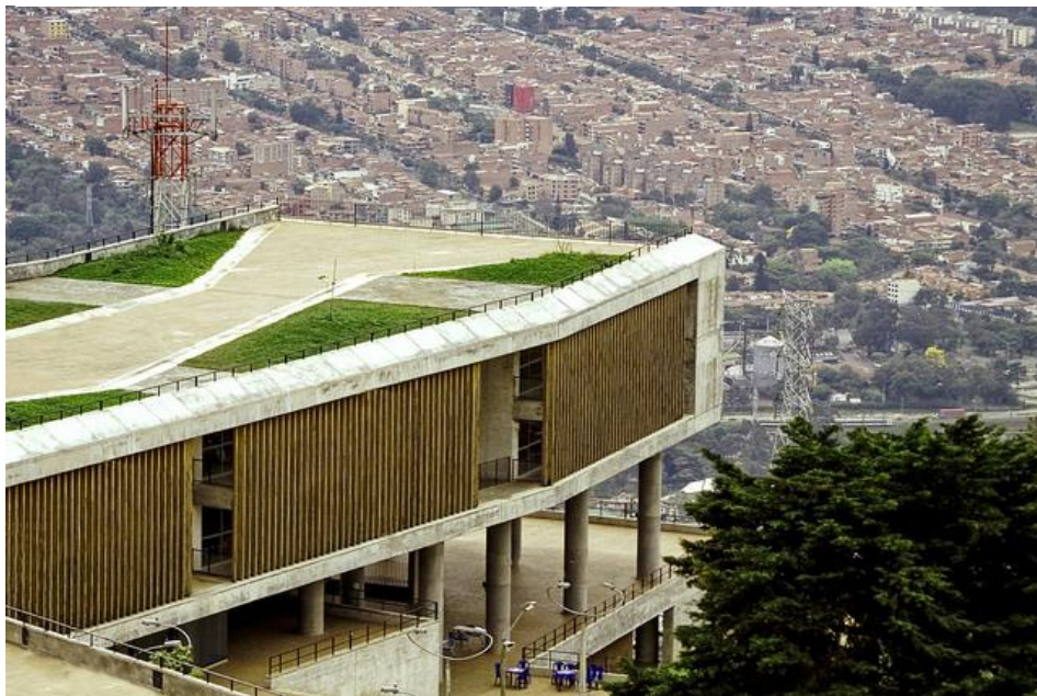
Figura 36: Vista do Pátio externo em cima da laje.
