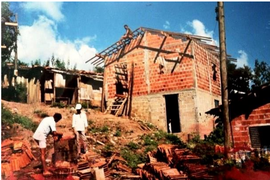
Figura 31: Processo de construção das casas favela em alvenaria.
