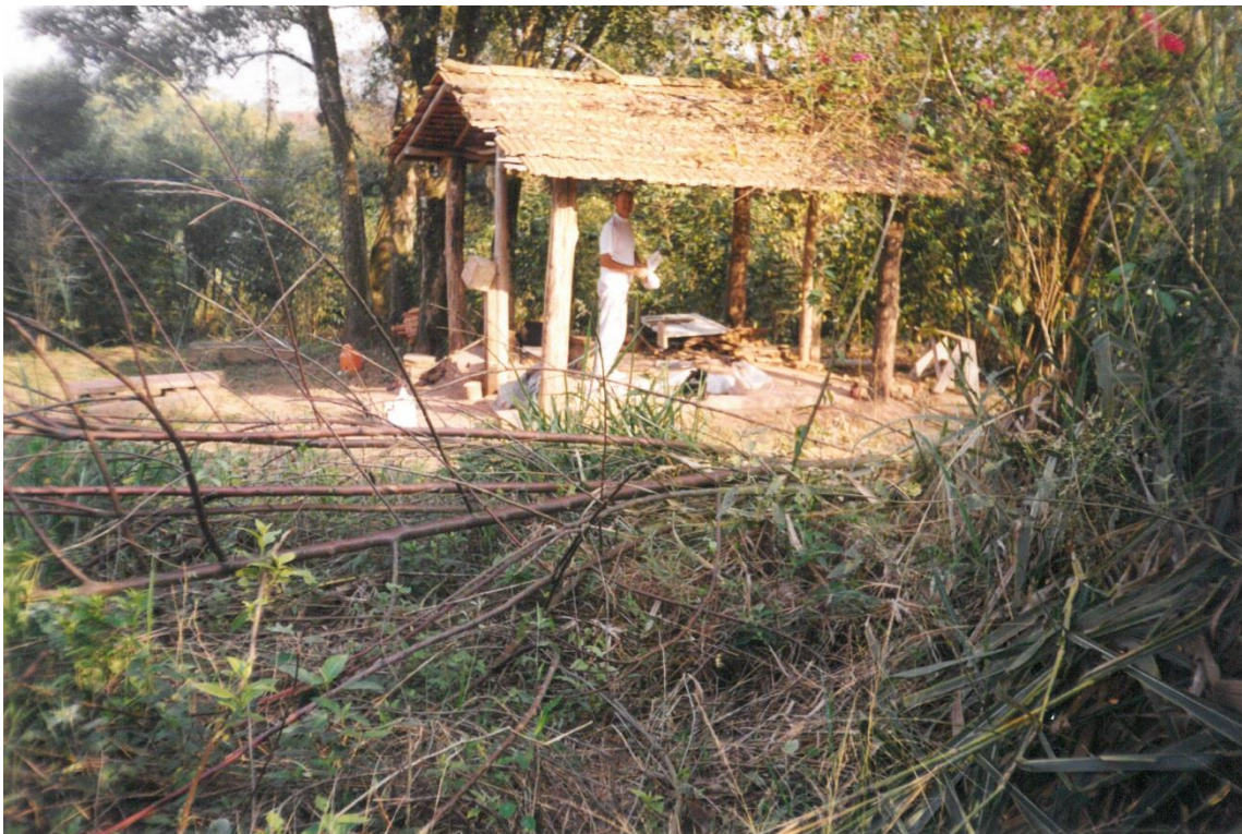
Figura 6: Sr. Onofre trabalhando na construção do rancho, sede da propriedade.
