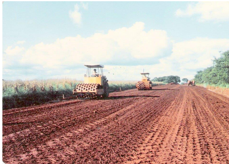
Figura 4 – Sistema de aplicação do solo-cal: pavimentação
