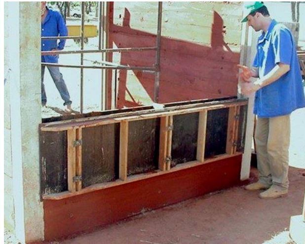
Figura 3 – Sistema de aplicação do solo-cimento: parede monolítica
