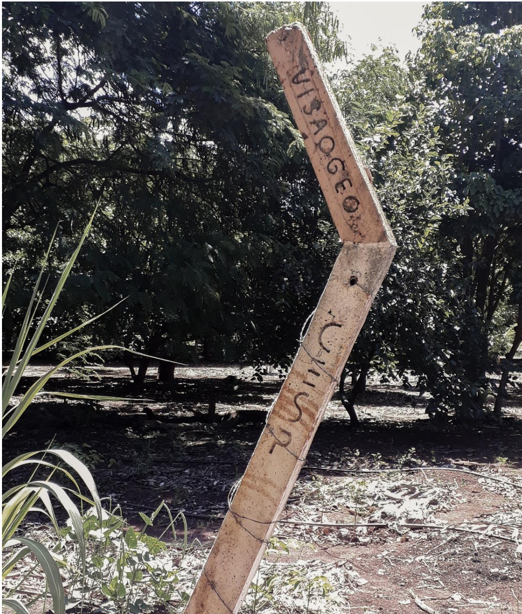
Figura 83: Coluna para fixação da tela de alambrado instalada pela CESP
