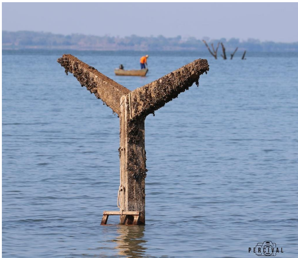
Figura 81: Pilar que suportava a cobertura da Estação Presidente Vargas
