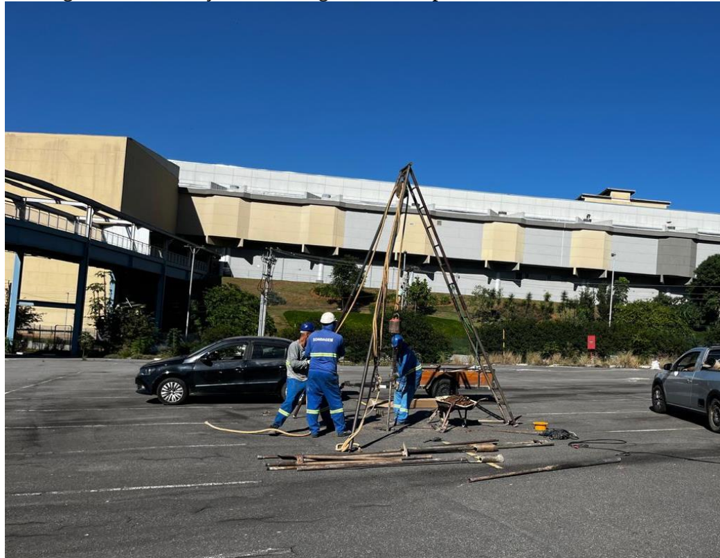
Figura 17 - Execução de sondagem manual para retirada do liner
