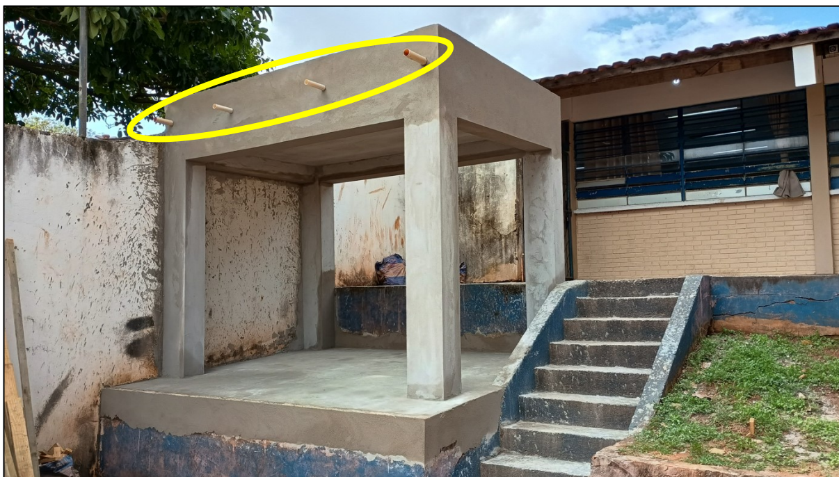
Figura 21. Drenagem por tubos na laje
