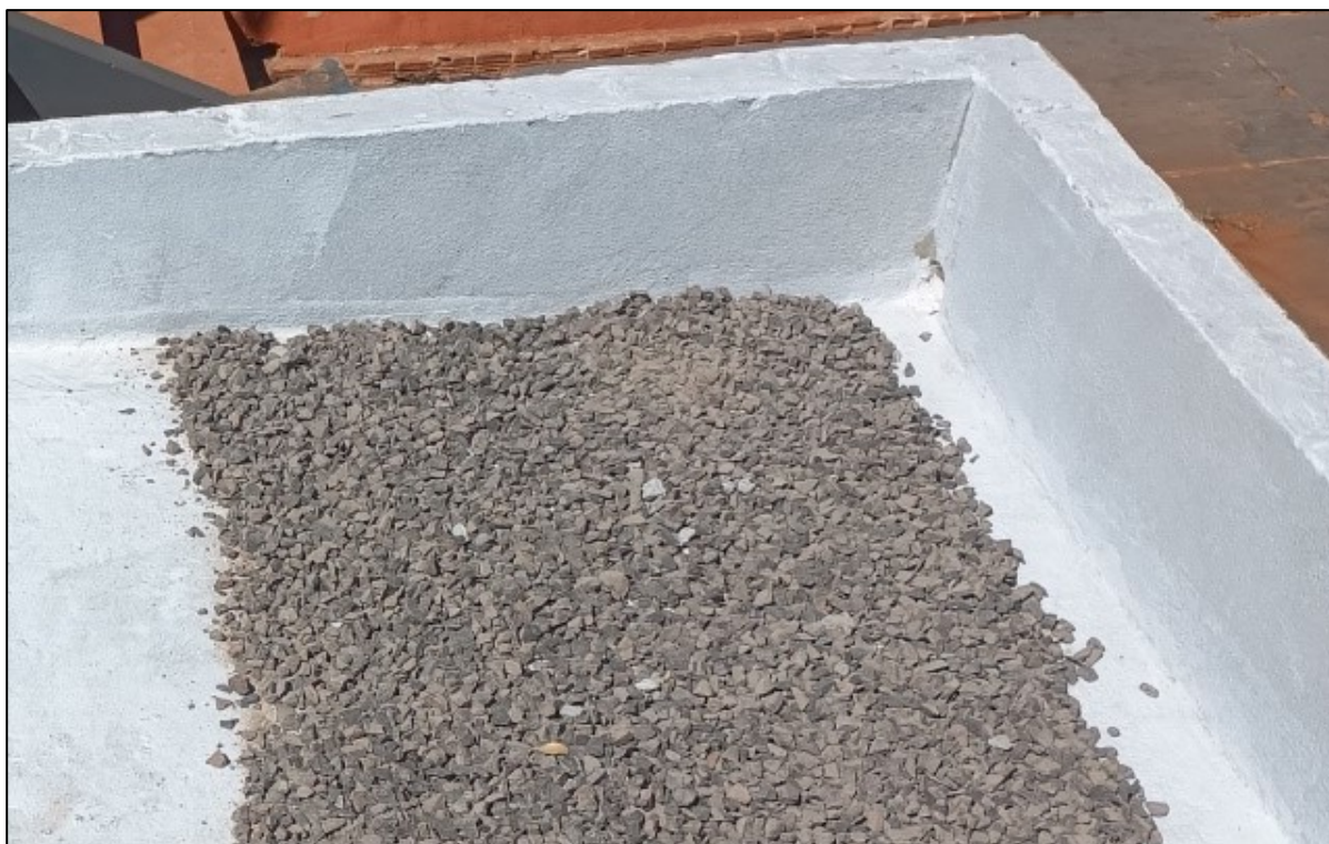
Figura 17. Camada de pedra brita
