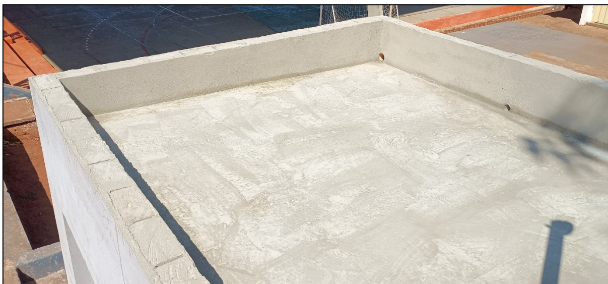
Figura 15. Após aplicação do impermeabilizante.
