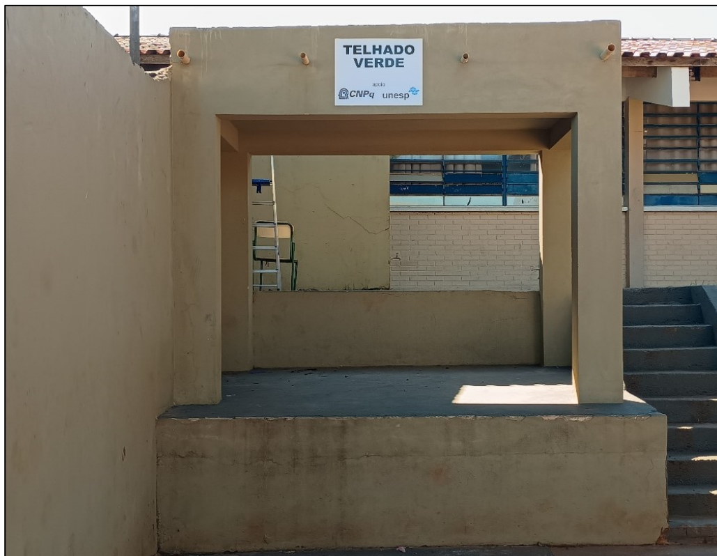
Figura 16. Finalização com pintura
