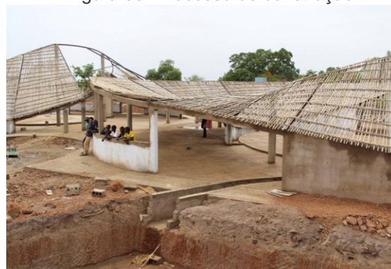
Figura 38: Processo de construção
