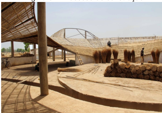
Figura 37: Processo de construção
