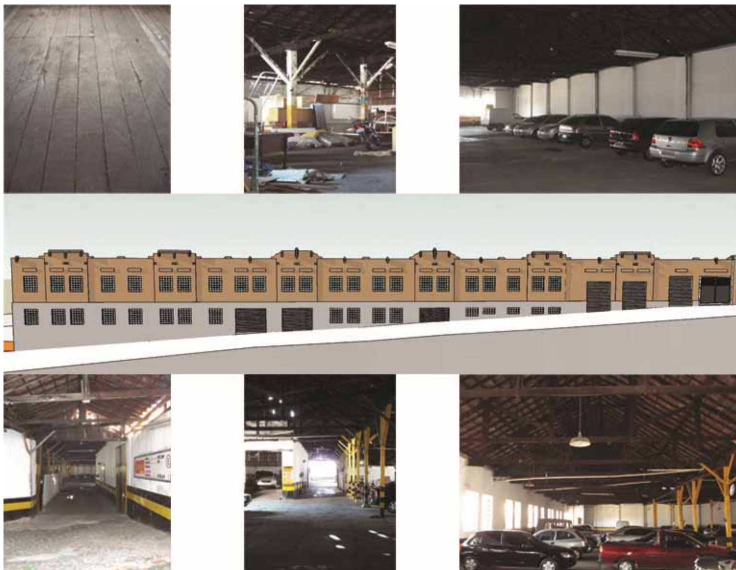
Imagem 17: Imagens seqüenciais internas (assoalho, pilares e capitéis, modulação estrutural, paralelepípedos, poucas aberturas, tesouras, vitrôs e estacionamento) e reconstituição da simetria da fachada principal pela maquete eletrônica. Fotos e maquete: Rafael T Simabuko
