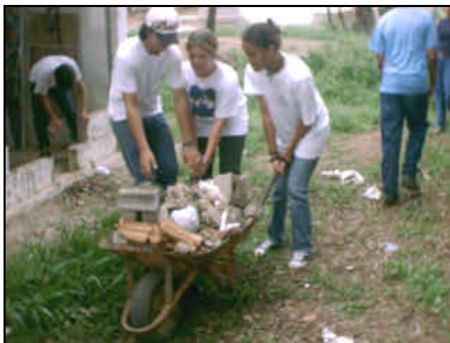
Figura 16 – Retirada do entulho e conserto das paredes
