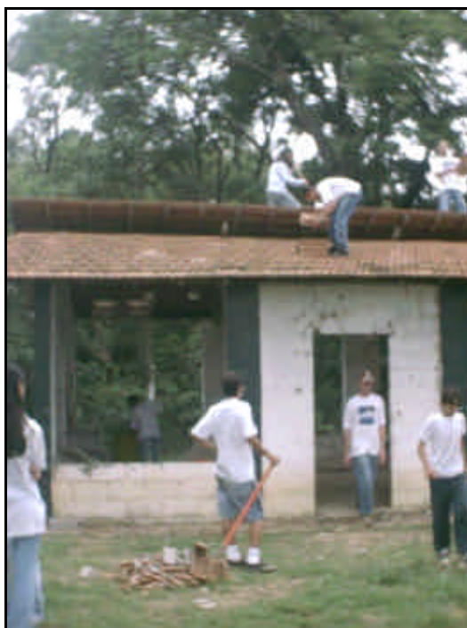
Figura 17 – Conserto do telhado
