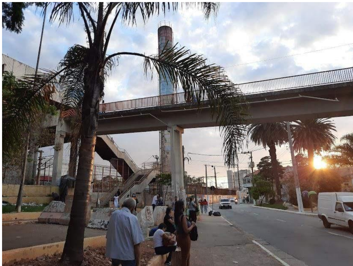
FIGURA 81: PERCURSO URBANO ACOMPANHADO DE HORTÊNCIA EMBARQUE COM VISTA PARA A PASSARELA DA UBS GUAIANASES I, 2022
