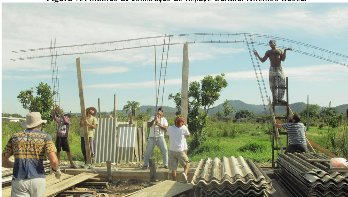
Figura 75: mutirão de construção do Espaço Cultural Kilombo Baobá.
