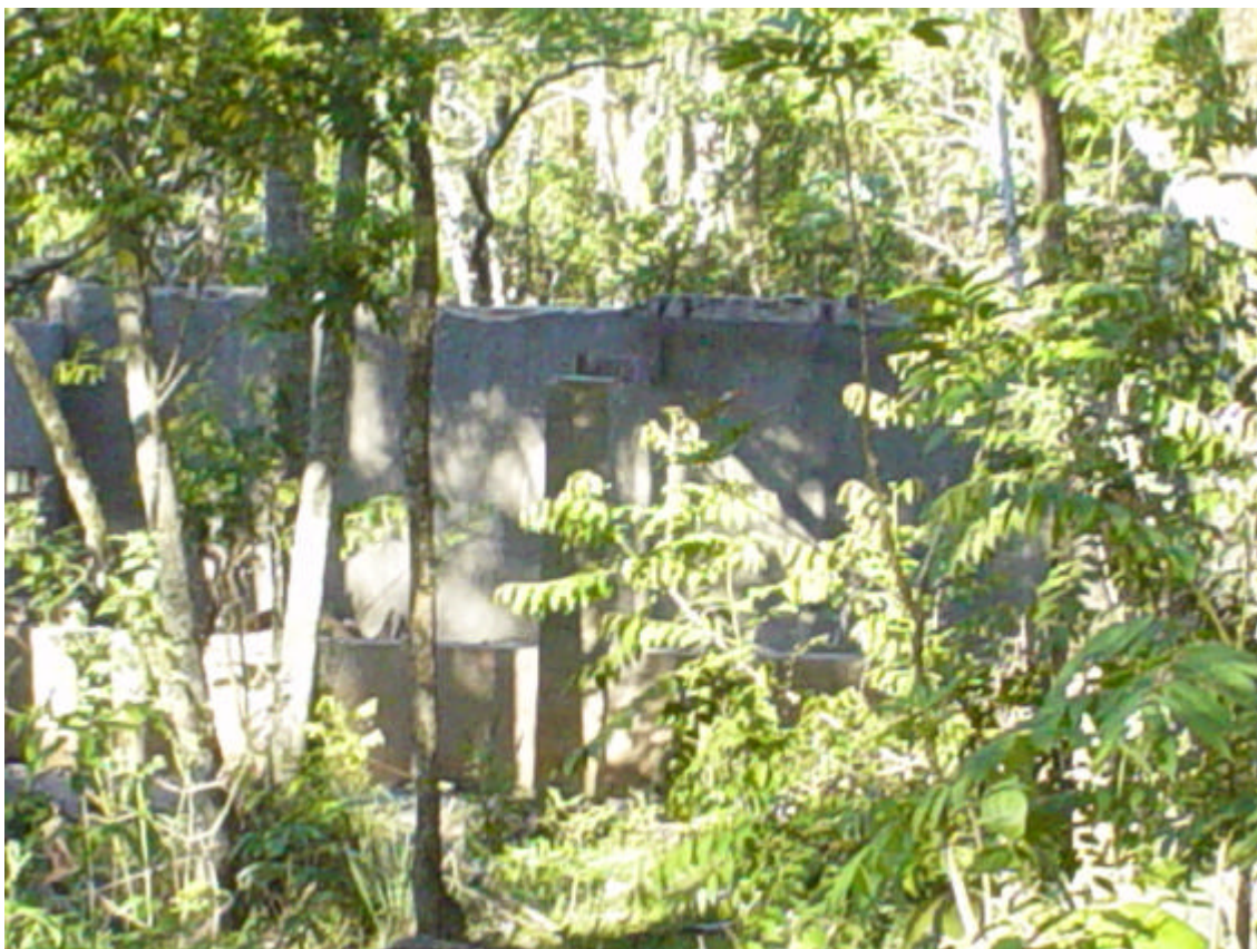
Figura 4 - Construções inacabadas no Parque Ecológico São Francisco de Assis bairro do Mato Seco - Itapetininga
