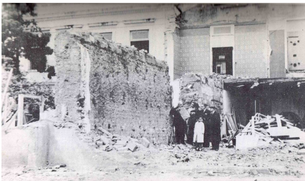
Figura 29: Descoberta a secular parede de taipa de pilão, no Pateo do Collegio. Fonte: Cardim Filho, 1965, s. p.
