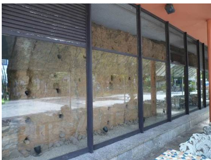
Figura 22: A remanescente parede de taipa de pilão no interior do Museu Anchieta. Créditos: Ivan Fortunato, fev./2013.
