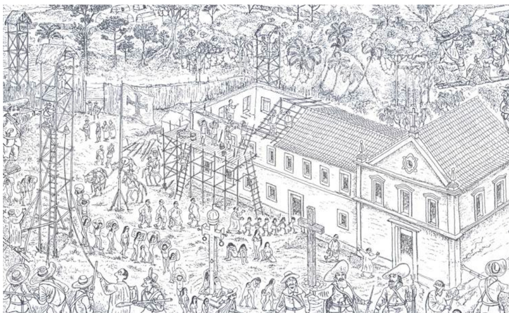
Figura 17: A muralha, no bico-da-pena de Torres. Fonte: Torres, 2004, s.p.
