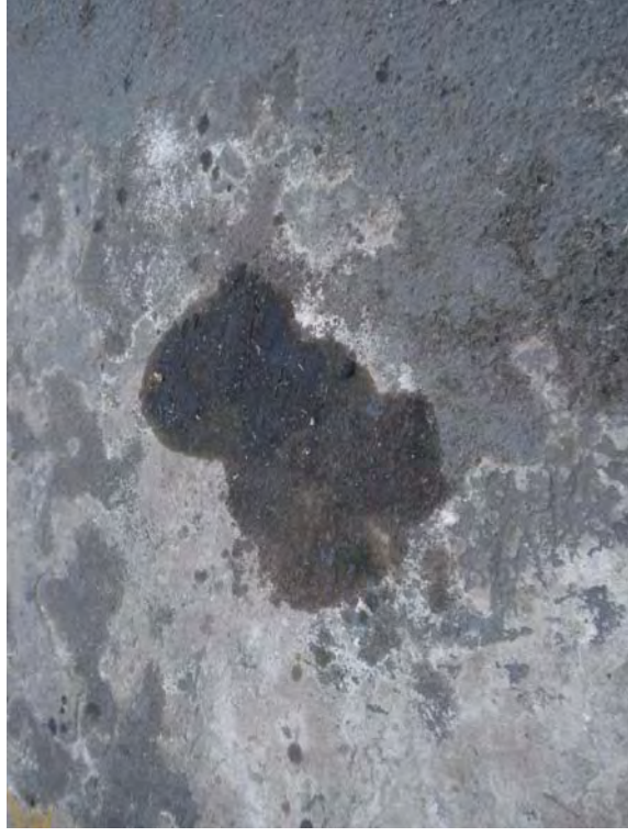
Foto 3: Combustível vazado em área não coberta do posto.
