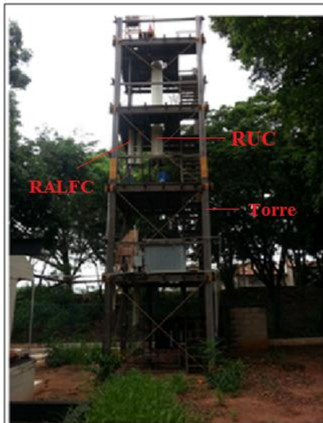
Figura 6- Estrutura de instalação e estrutura para a fixação do RALFC
