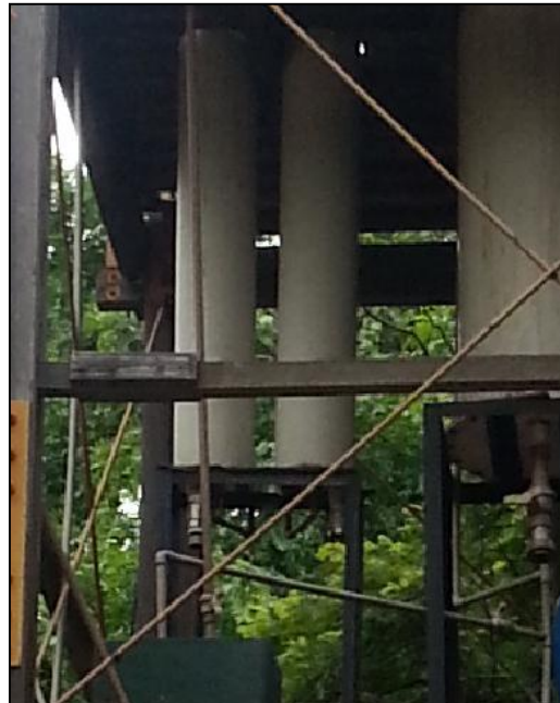
Figura 14- RALFC instalado no local de pesquisa
