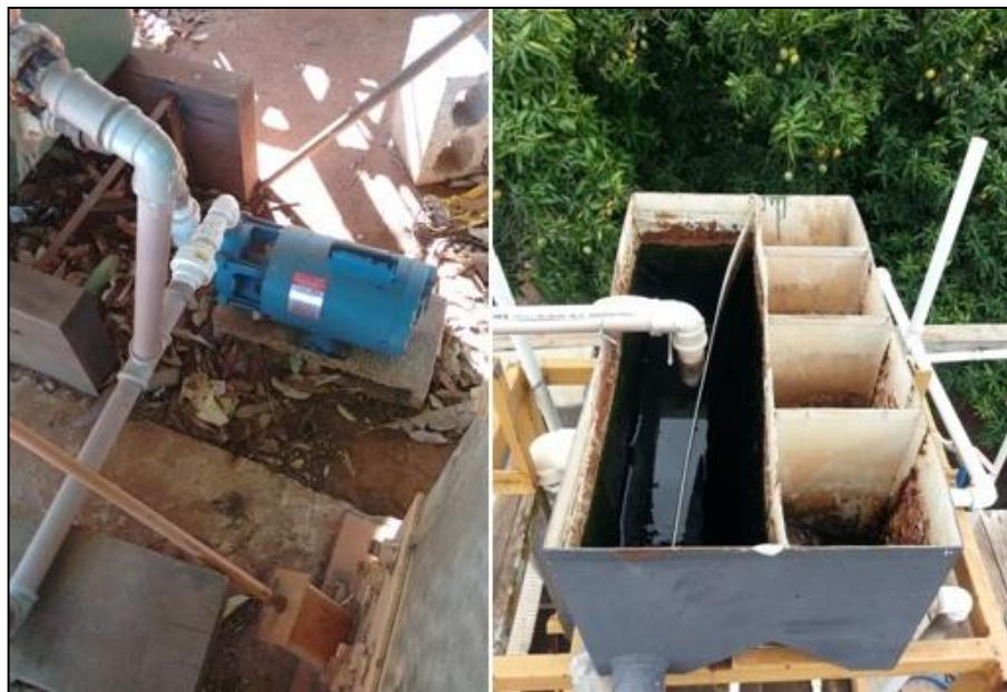
Figura 18- Bomba de adução centrífuga e caixa de nível constante denominado Ponto 1
