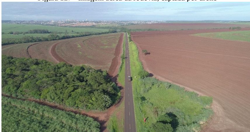
Figura 127 - Imagem aérea da rodovia, captada por drone
